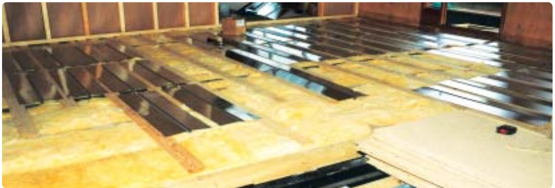
Fig. 2.11 - Rastreles, aislamiento y difusores.
