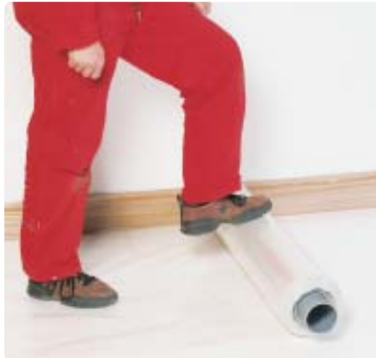
Fig.2.4 - Colocación del film de PE
