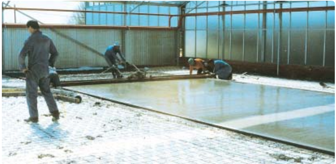
Fig. 2.9 - Vertido del mortero de cemento
