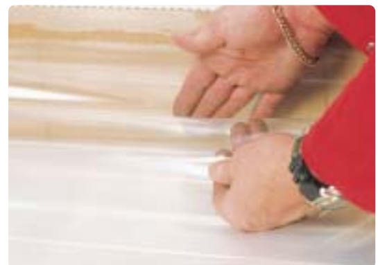
Fig.2.2 - Colocación del zócalo perimetral
